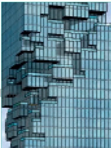
*Wegen der ungewöhnlichen Form mussten Windkanaltests mit Winden aus 36 Richtungen durchgeführt werden.*
