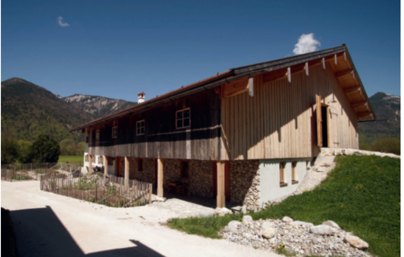
Unbehandelte Bretterfassade an einer Tenne (Planung: werkraum a)
